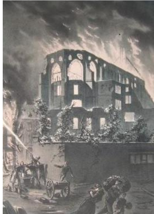
24 Août 1870 : incendie de la bibliothèque
